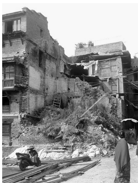
写真3 バクタプールの倒壊状況
