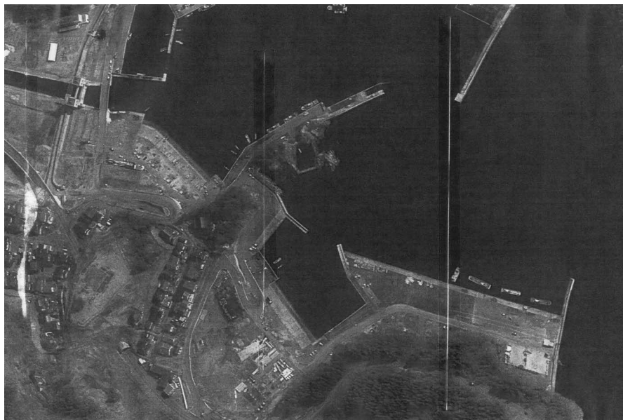
写真-2 修復した石浜漁港と漁業関連施設（2013年5月）
