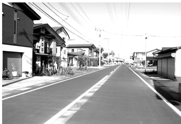
写真11) 2010年11月撮影 造成住宅団地：中央道路
