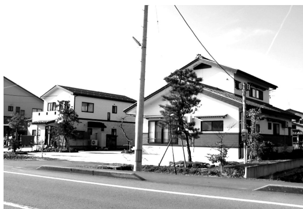
写真18) 2010年11月撮影 近傍集落の住宅群
