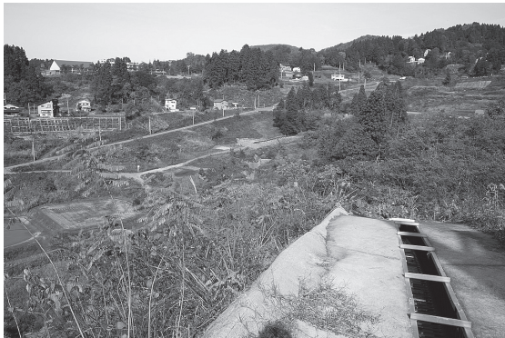
図-11 ④山古志支所 (2)
