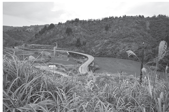
図-18 ⑫東竹沢天然ダム
