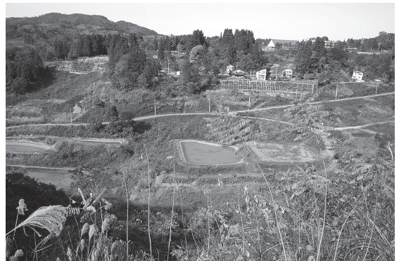
図-10 ④山古志支所 (1)
