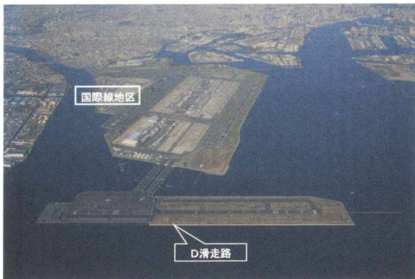
図-1 再拡張プロジェクトが完成した羽田空港
