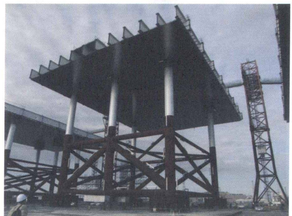
図-4 栈橋部に用いられた高さ約35mの鋼製ジャケット
