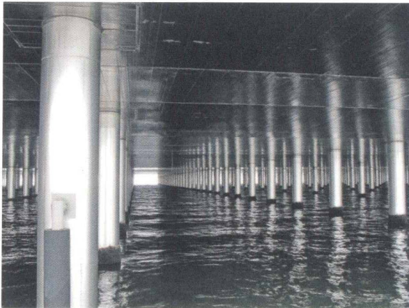
図-7 棧橋上部工と海面の間の美しい空間
