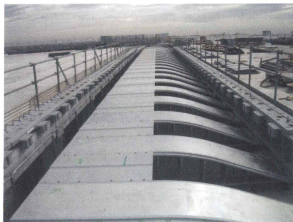
図-6.2 施工中のローリングリーフジョイント
