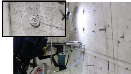
写真2 円柱状シアキー施工状況
