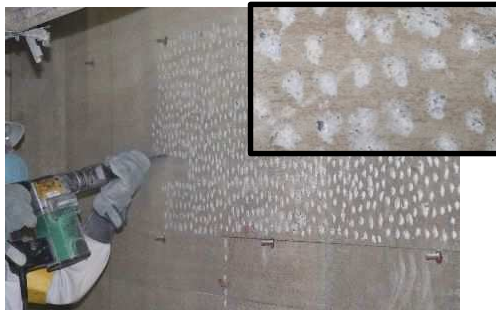
写真1 チッピング施工状況
