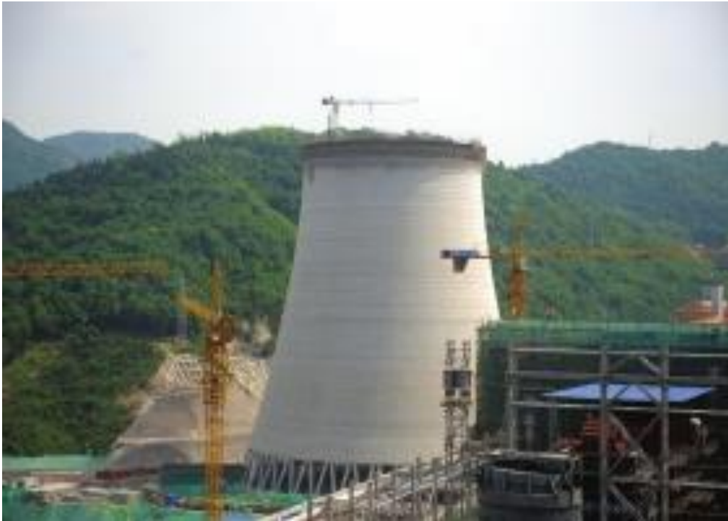
図 4-8 長沙市黒糜峰ゴミ焼却処分場建築中（出典：湖南省政府、2017）
