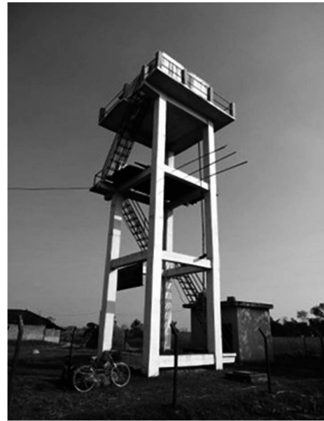
写真3 水道用給水塔
