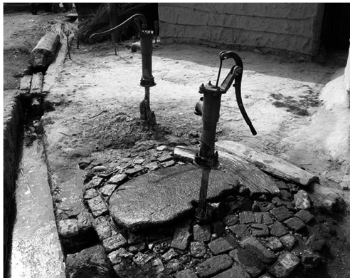
写真2 管井戸・手押しポンプ
