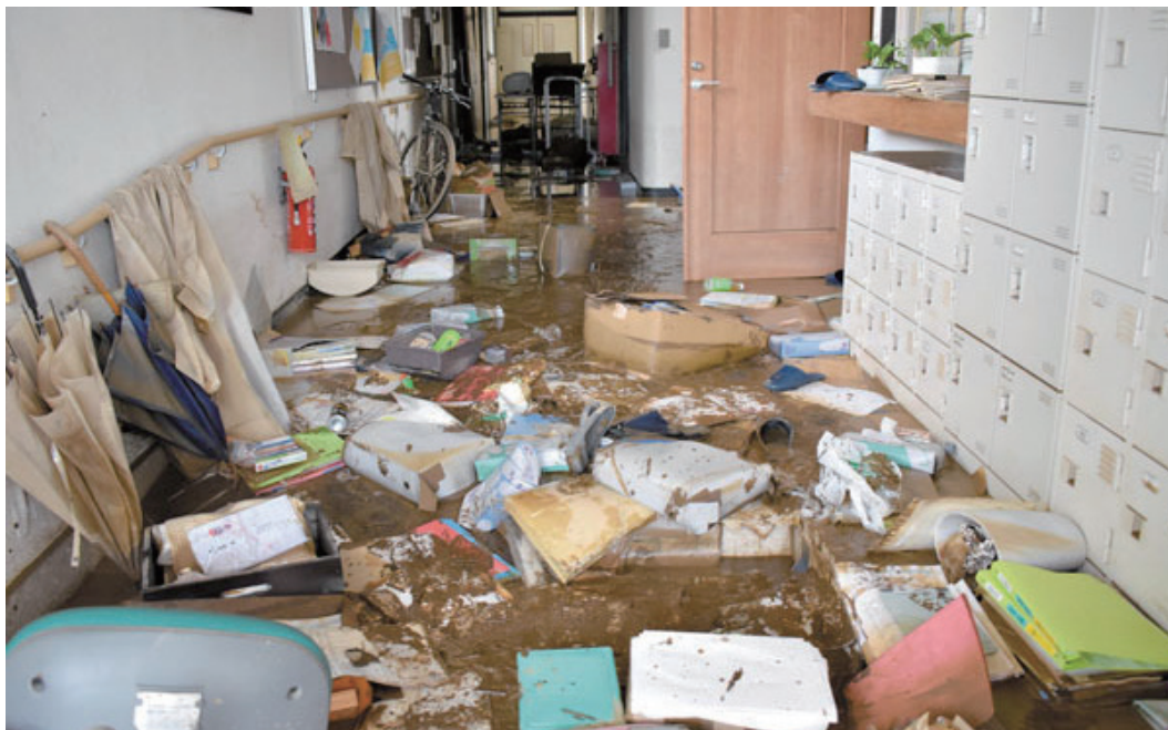
(写真1) 発災直後のH施設 (施設内部)
