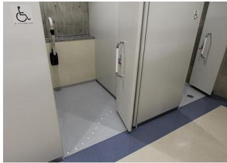
図 6-1 床に示された折戸の軌跡
