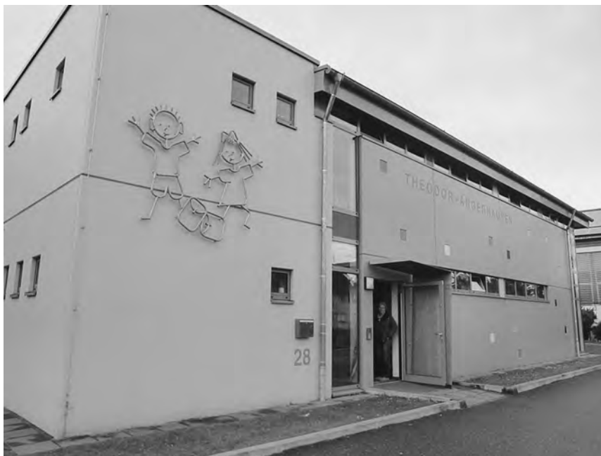
写真1 小学校に隣接して建てられている学童保育（OGS）施設
