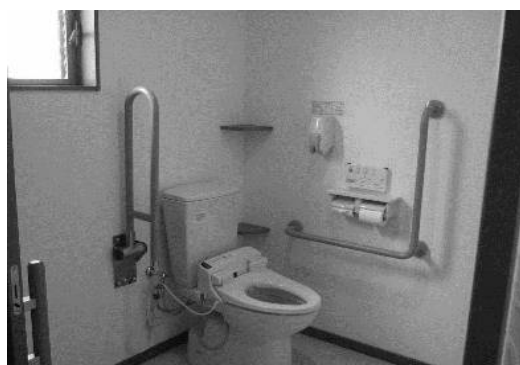
車いす使用者用便房
