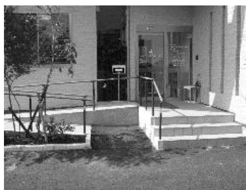
アプローチ：スロープ、自動ドア
