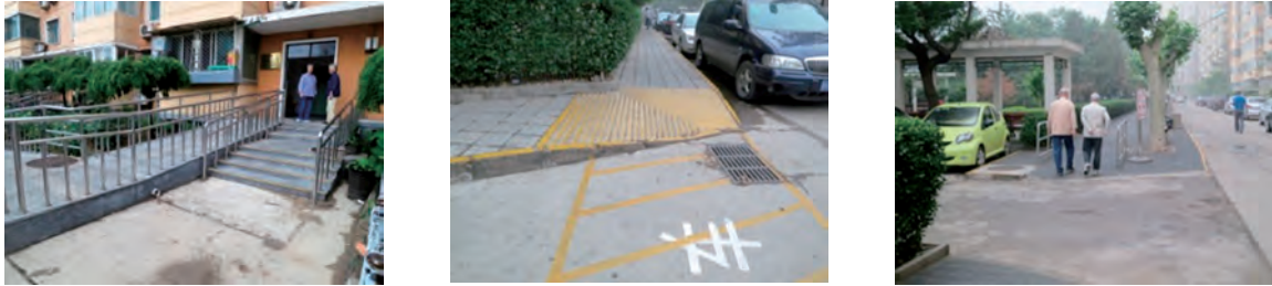
写真3 北京市内の高齢化が進む団地のBF改修例
