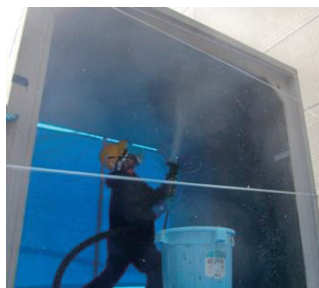
図-2 吹付け養生施工状況
